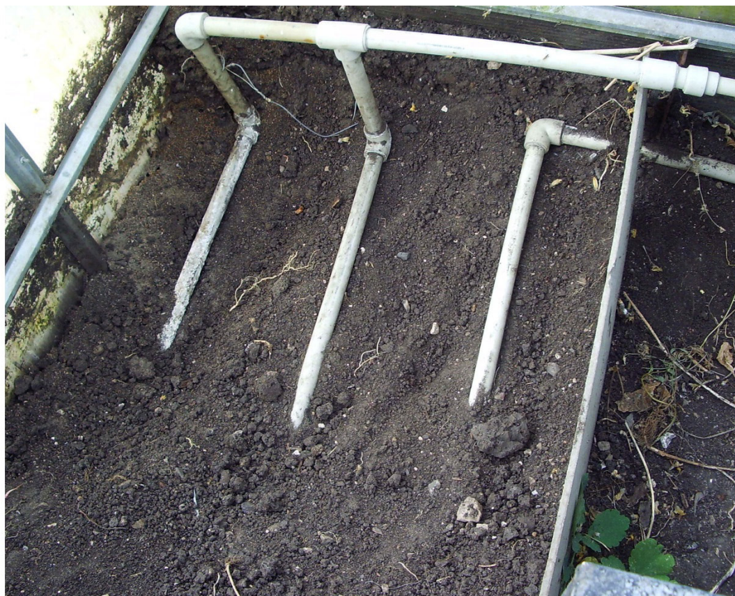
Подогрев грунта в теплице Степана Атояна.
