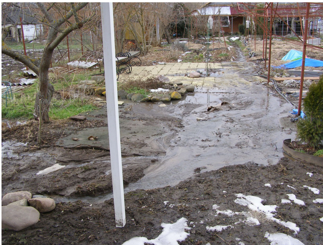
Мой склон – всего 2°. Но для весенней воды это очень круто! Ошибся с направлением дренажной канавы – и вот результат.
