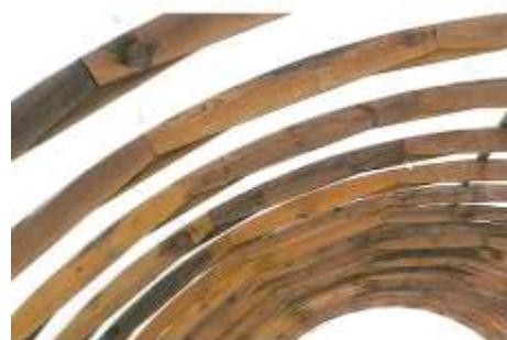
Опыт показал: если нижние концы дуг закреплять на забетоненных стальных стойках, для всей конструкции достаточно трёх продольных реек вместо десяти.
